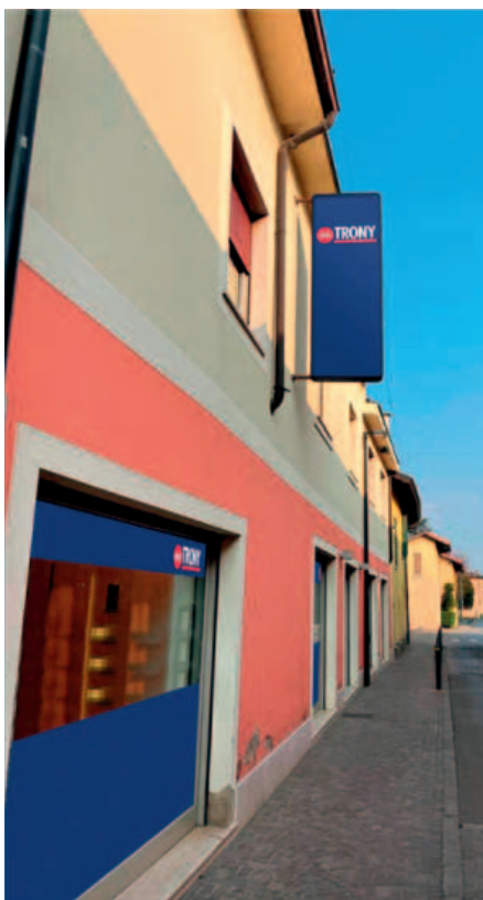
Il pv di prossimità Mini-Trony nel centro di Castegnato (BS)
